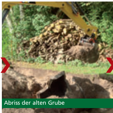
Aushub für Mehrkammergrube
